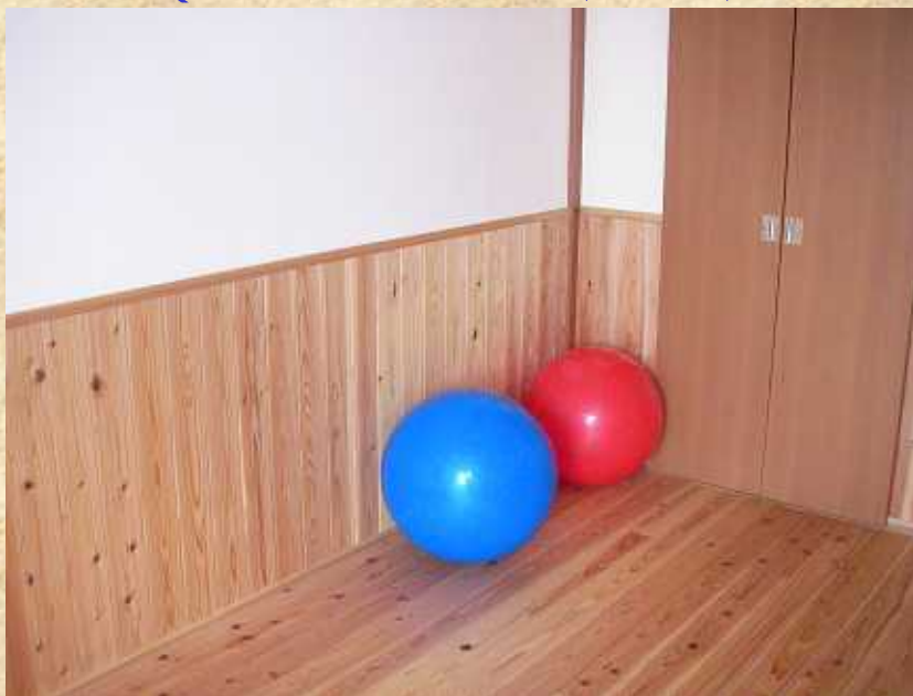
各居室（スギフローリング、腰壁、漆喰壁）
